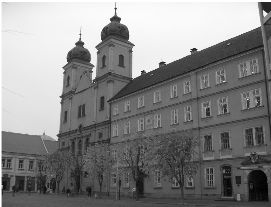
Obr. č. 4: Budova bývalého trenčinaskeho jezuitského kolégia
